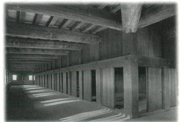
大天守1階 西側入側 (名古屋城総合事務所所蔵ガラス乾板写真)
